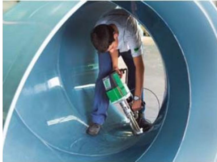
Рис.3.4. Экструзионная сварка внутреннего шва полимерной трубы
